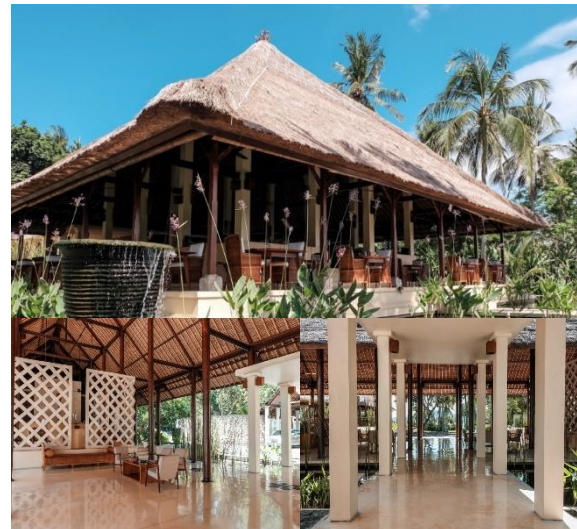
Gambar 9. Implementasi struktur tradisional Bali pada bangunan lobby Hotel Alila Manggis Sumber:
