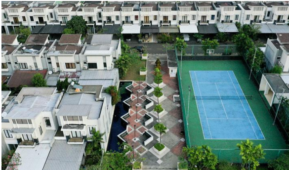
Gambar 2. Perumahan mewah kota Jakarta yang dibangun di atas atap Gedung Thamrin City (Bagian bawah gedung perkantoran, mall, lantai teratas adalah perumahan).
